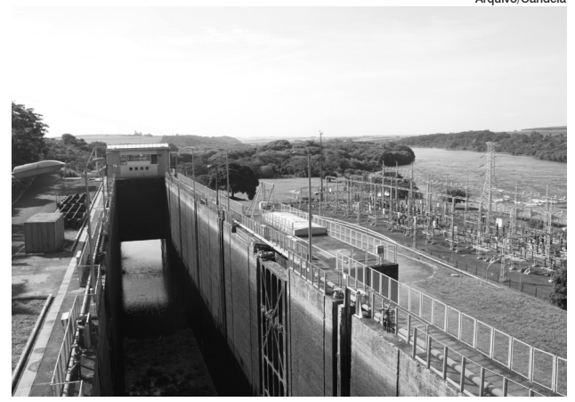
Eclusa de Bariri: obra teve início em 2014 e até o momento não foi concluída
